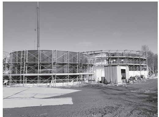
建設中の発酵槽
